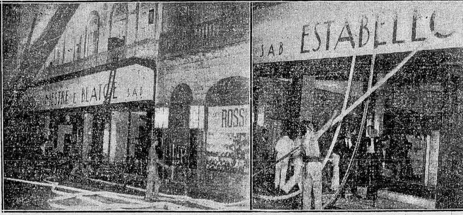
Dois aspectos da fachada dos Estabelecimentos Mestre & Blatgé e a frente do predio onde se suppõe tenha tido inicio o fogo
